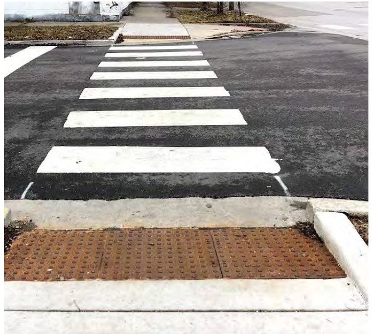
ADA Curb Ramp
